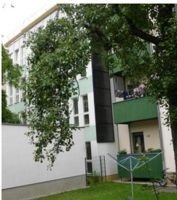
Abbildung 7: Solarfassade in der Altbauanierung
